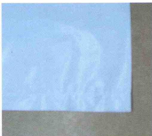
Foto 1 – Detalhe da solda “reta” no fundo
